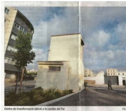
Centre de transformació ubicat a la rambla del Far
